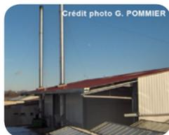
La SAS CHAVANNE établie à Foissy / Vanne (89) est spécialisée dans la culture de concombres sous serres. En 2008, le gérant a investi dans une chaufferie biomasse de 2 X 3 MW utilisant la paille. L'installation, opérationnelle depuis 2009, consomme environ 6000 t de paille récoltée localement (moins de 20 km) et répond parfaitement aux objectifs recherchés : une maîtrise des coûts d'exploitation, la création
